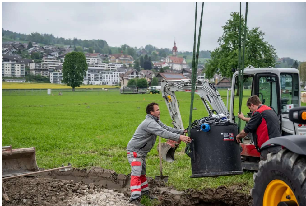
Thomas Schurtenberger (rechts) und Thomas Hofstetter platzieren die Pumpe für das Abwasser.
