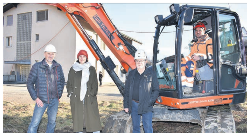
Die Bauherrschaft der Immo Roos AG beim Spatenstich: (von links) Walter Roos, Rebecca Weber-Roos, Walo Durrer und Baggerführer Tobias Egli. Foto Ferdi Brühlmann
